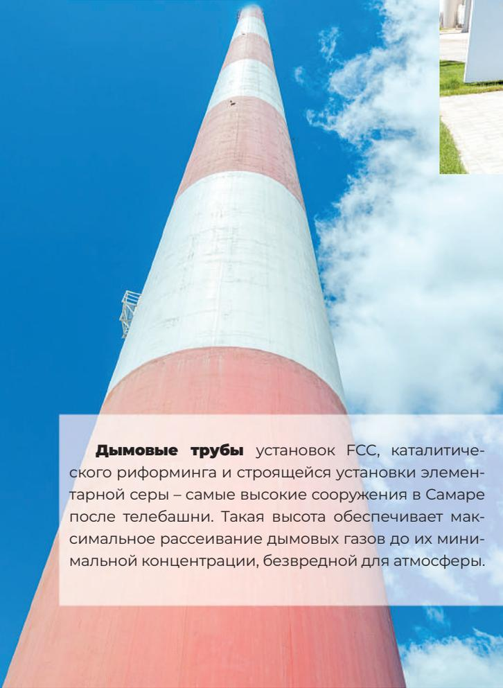
**Дымовые трубы** установок FCC, каталитического риформинга и строящейся установки элементарной серы – самые высокие сооружения в Самаре после телебашни. Такая высота обеспечивает максимальное рассеивание дымовых газов до их минимальной концентрации, безвредной для атмосферы.
